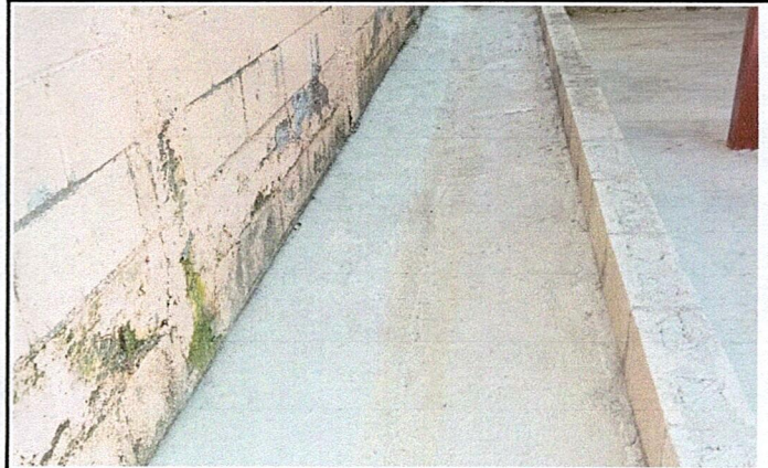
Foto 2: Mejoramiento del manejo de aguas pluviales con cuneta de concreto.
