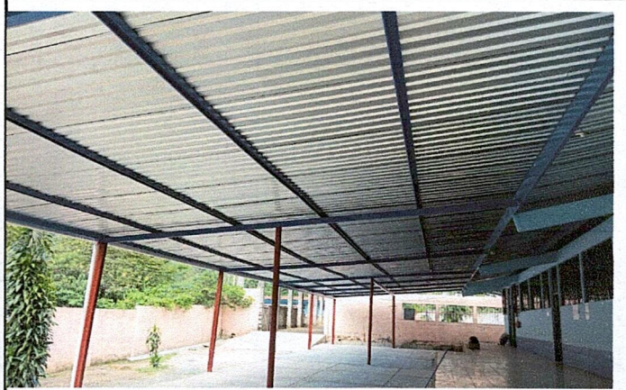
Foto 4: Vista interior del techo.
