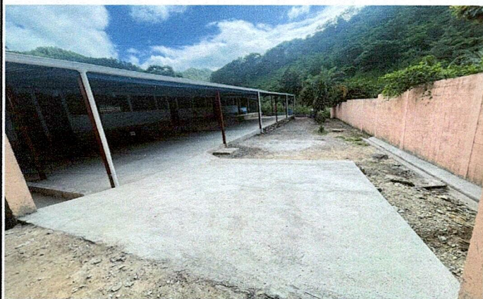
Foto 3: Mejoramiento de entrada con losa de concreto tipo rampa.
